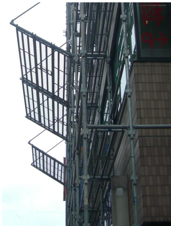
④ 隣接したスパンに同様の手順で取り付け、踏板を手前から設置する
