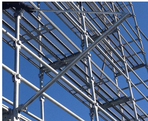
② 下部クサビ取付位置から3コマ上に上部クサビを差し込む
