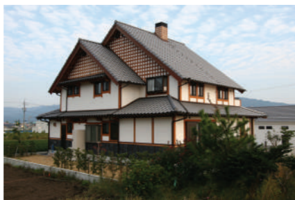
T邸：塗布箇所/屋根：300㎡、外壁：180㎡他。
