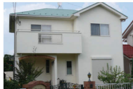
S邸：塗布箇所/屋根：94㎡、外壁：140㎡。
