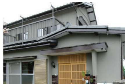
K邸：塗布箇所/内壁・天井：40㎡、外壁：260㎡。
