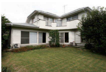
M邸：塗布箇所/屋根：130㎡、外壁：140㎡。
