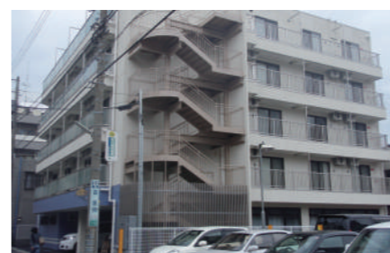
老人ホームの屋上・外壁に塗布。
