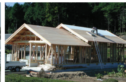
瓦屋根家屋の野地板に塗布。
