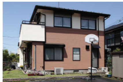
O邸：塗布箇所/屋根：90.9㎡、外壁：156.95㎡。
