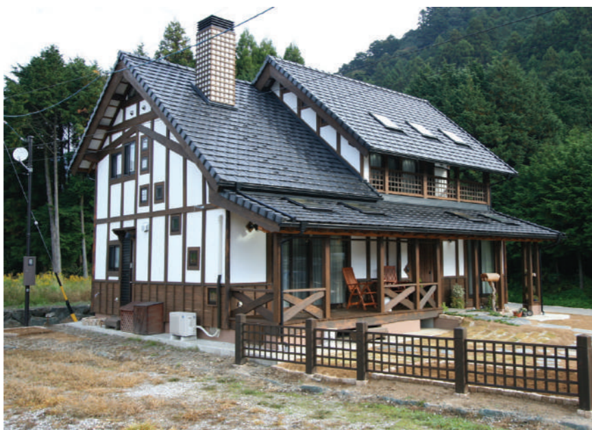
塗布箇所/内壁・天井：約 415㎡、屋根（ルーフィング）：約 160㎡、外壁：約 175㎡。
